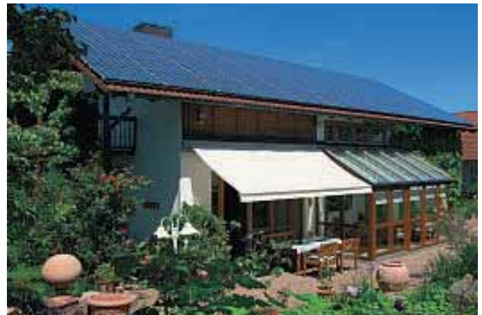
Ob Privathaus, Bürogebäude oder Fertigungshalle, eine optimal errichtete Photovoltaik-Anlage wirkt keinesfalls störend. Außerdem wird diese Energiegewinnung beachtlich gefördert und schont die Umwelt. Fotos: R. P. Reichel
